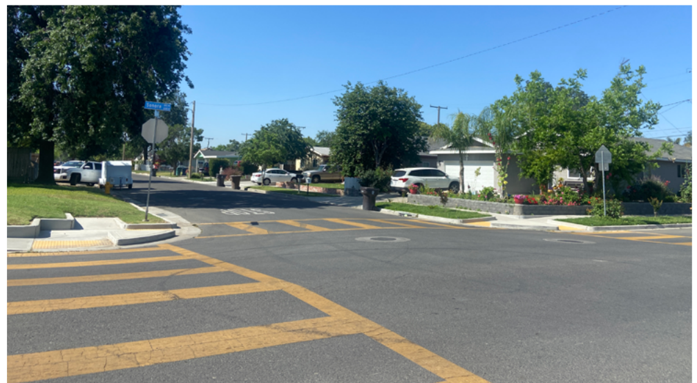
ARRIBA: Tres de los cuatro cruces peatonales amarillos, una señal de alto y una señal de ceder el paso aumentan la visibilidad de los peatones en la intersección de la Calle Santa Clara Sur/Calle Sonora Oeste.
