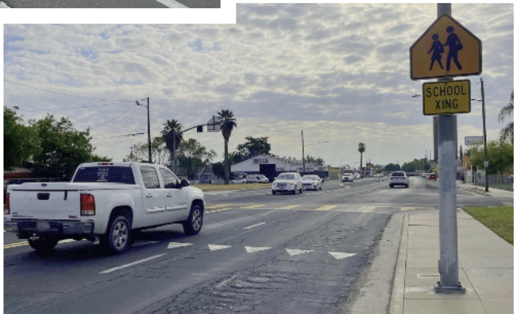
ARRIBA: Un cruce de peatones amarillo de alta visibilidad con una señal peatonal intermitente en la Avenida Inyo Oeste (SR-137) alerta a los conductores sobre estudiantes que cruzan en el área.
