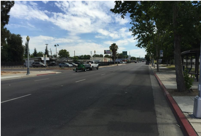
FALTA DE CRUCE PEATONAL MARCADO EN UNA INTERSECCIÓN T QUE DIRIGE EL PEATON A UNA PARADA DE AUTOBÚS EN BLACKSTONE AVENUE
