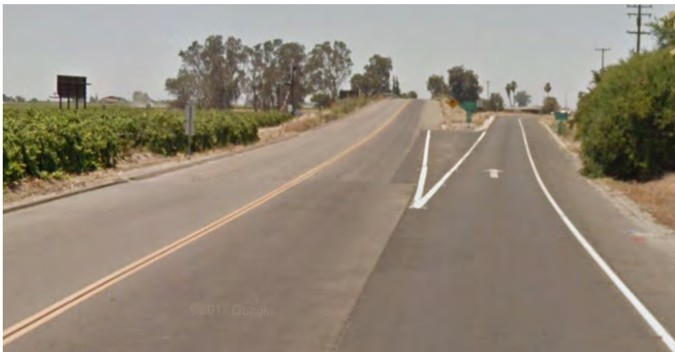
Vista de la esquina de Avenida Adams Este y Calle 4 Norte donde una cerca y vegetación obstruyen la vista entre las carreteras
