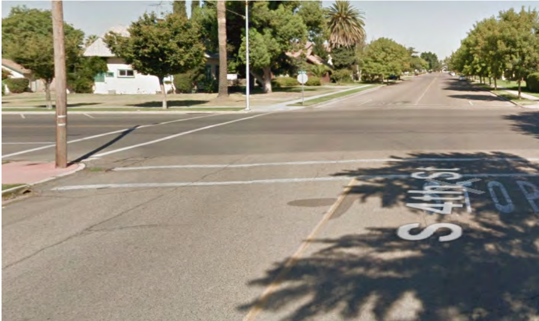
Intersección de Calle 4 Sur y Avenida Merced Este donde existen problemas de visibilidad por causa de los carros estacionados que bloquean la vista para aquellos girando hacia la izquierda en la Calle Merced Este.
