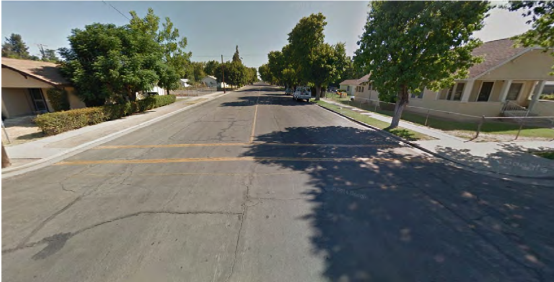
Intersección de Calle Main Este y Calle 4 Sur mostrando la única rampa de banqueta disponible
