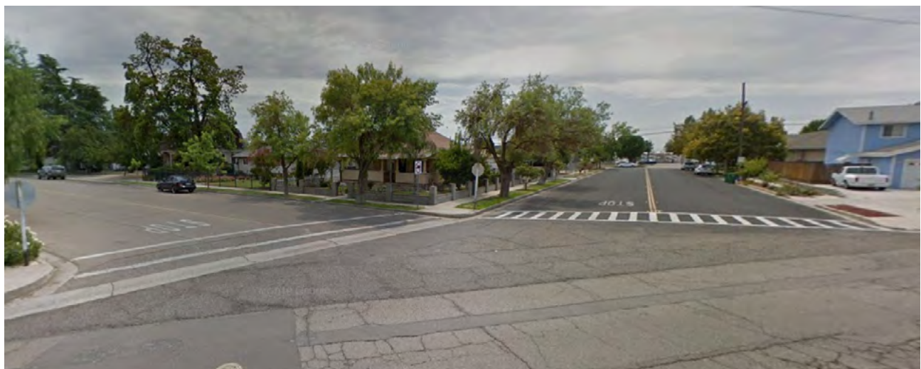
La Avenida Adams Oeste/Calle Stockton Este/Calle 6 Norte tiene alguna infraestructura pero faltan rampas que causan dificultades para algunos peatones.
