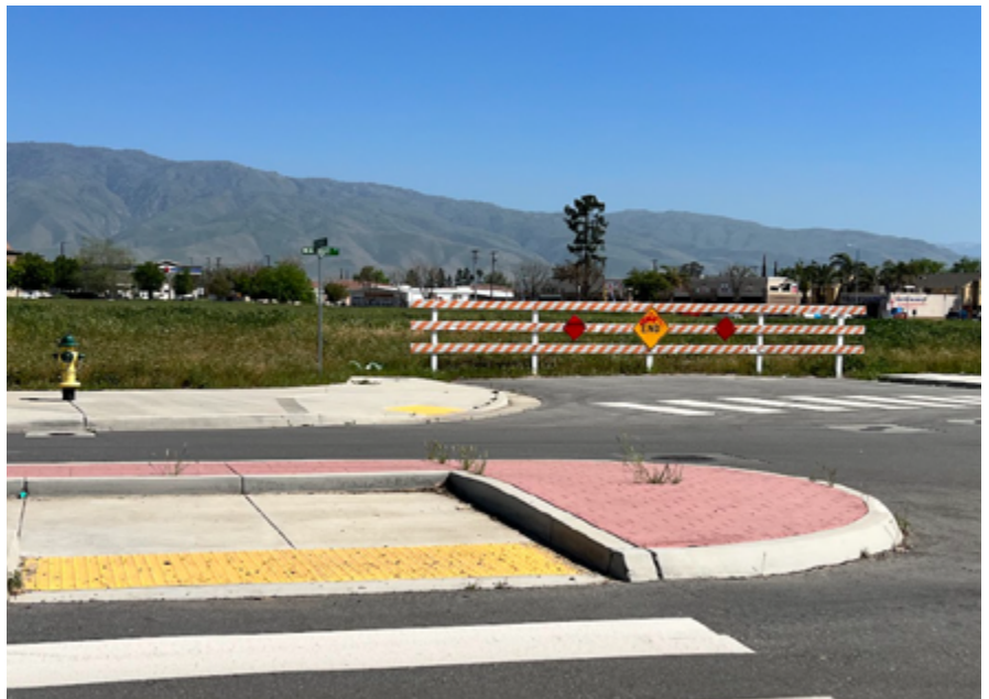
ARRIBA: La Calle Walnut Norte tiene un carril de bicicletas con rayas y protegido y una isla de refugio peatonal.
