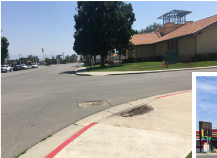
ARRIBA: El lado oeste de la intersección de Calle 4 y Paseo Campus carece de un cruce de peatones marcado, cúpulas truncadas en la rampa de la banqueta y una señal de alto. La acumulación de escombros en la rampa de la banqueta también podría convertirse en un problema de drenaje.
