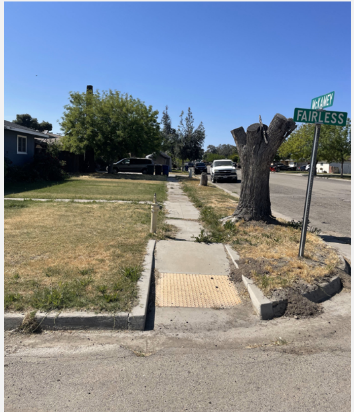
En la intersección de West McKamey Avenue y Fairless Avenue, la vegetación crecida obstruye una banqueta desnivelada y agrietada que termina abruptamente más adelante en West McKamey Avenue.
